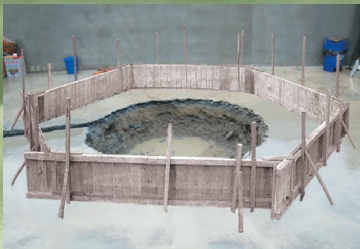
大型金爐基礎結構
