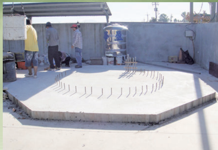
大型金爐基礎結構
