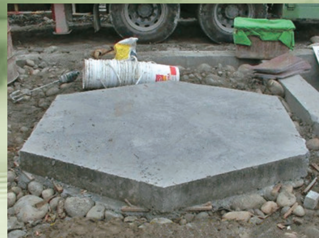
小型金爐基礎結構
