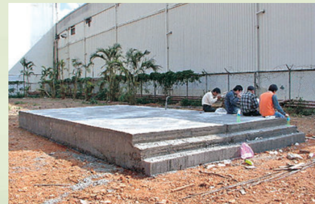
廟基礎參層梯結構
